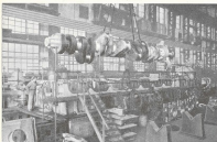
Montaggio di un motore Diesel Ansaldo - Fiat tipo 762 sovralimentato, 4 cilindri a iniezione, del peso di 10 tonnellate, viene provvisto del basamento per motori approntato.
